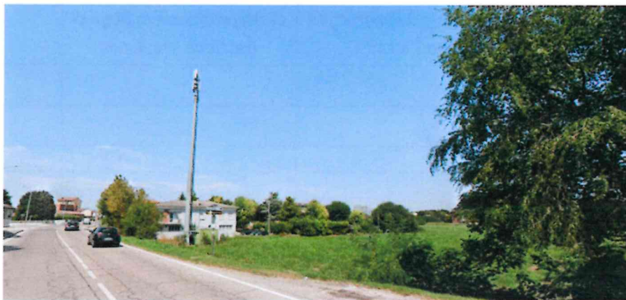
RILIEVO FOTOGRAFICO ANTENNA ESISTENTE
